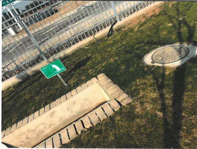
图 4-1 厂区污水排口
